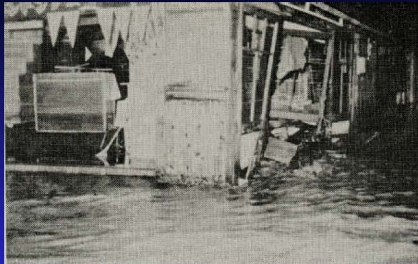
民家の被害状況(中の島)
