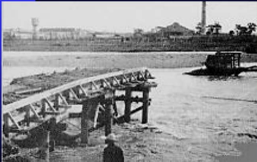
伊丹市桑津橋の流失状況
