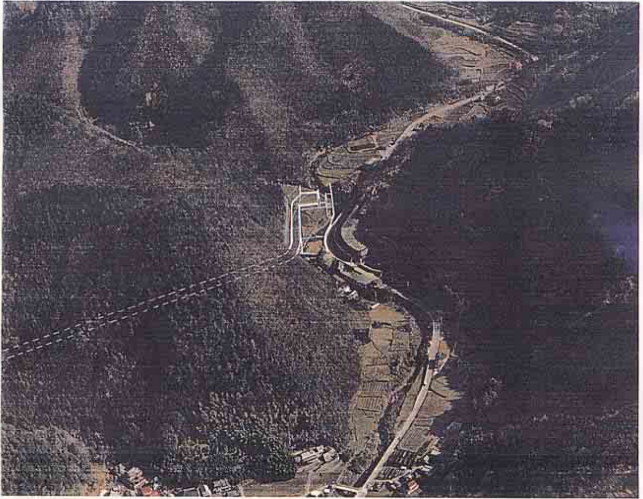
〔分派堰設置予定区域（箕面市上止々呂美地区）の現況〕
