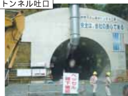
トンネル吐口
