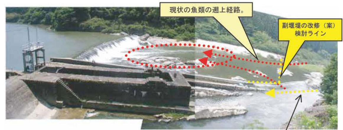
相楽発電所取水堰堰下流の魚類の遡上経路
