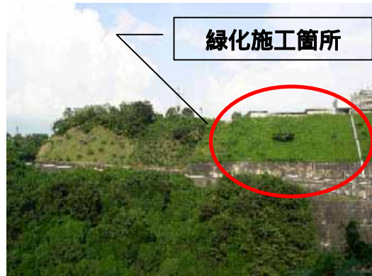
緑化された法面の状況
