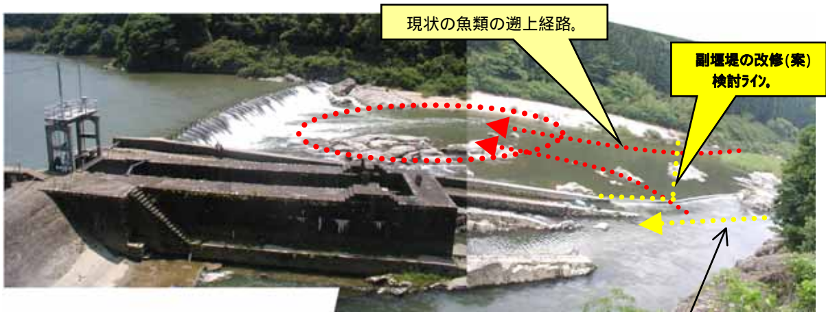
相楽発電所取水堰下流の魚類の遡上経路
