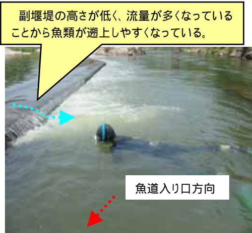
相楽発電所取水堰 副堰堤の現状
