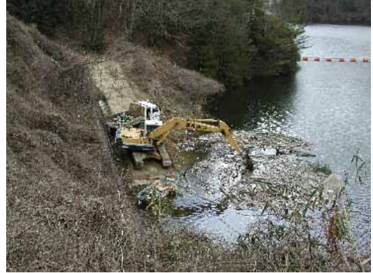
流木の引き上げ状況
