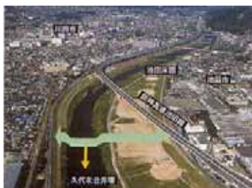
写真 1-2-2 河川の横断方向の連続性分断 (水域～高水敷・堤防～河川区域外)
