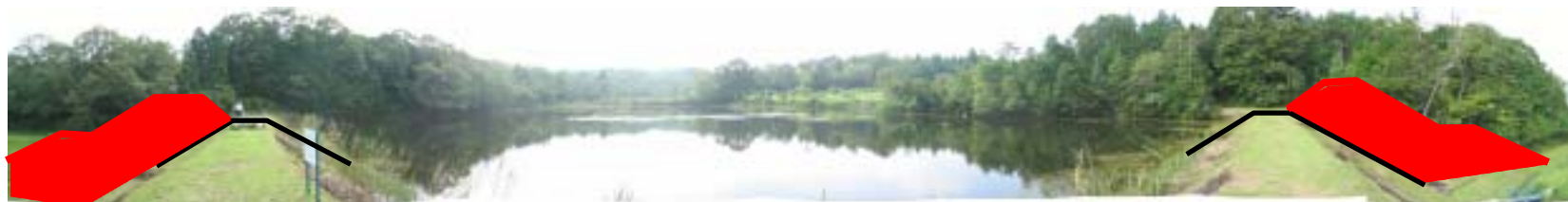
【ため池状況写真】
