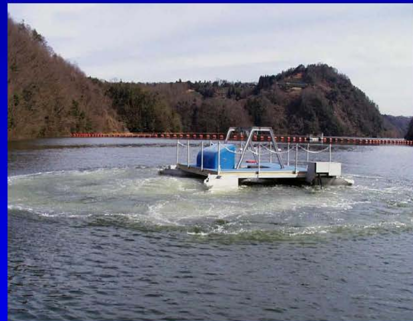
浅層曝気設備稼働状況
