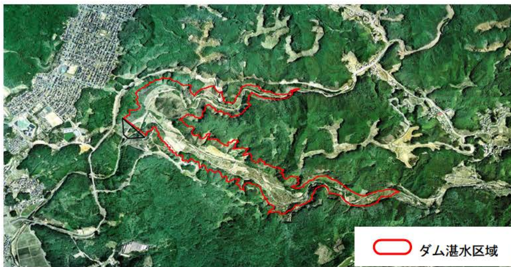
図 1.1.4 川上ダム事業実施予定区域周辺の航空写真
