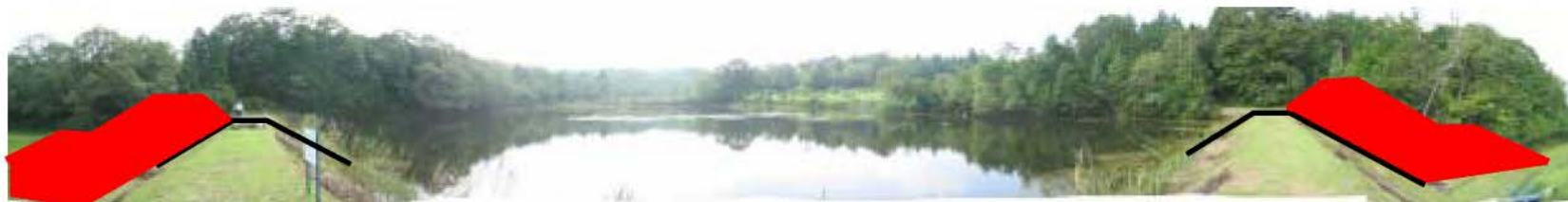
【ため池状況写真】
