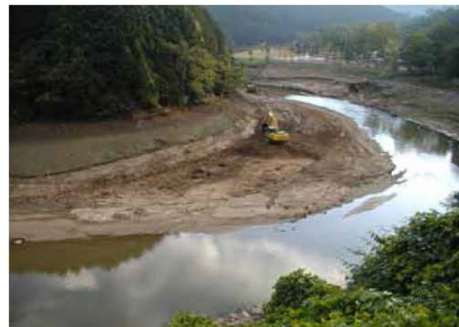
室生ダム堆砂除去状況
