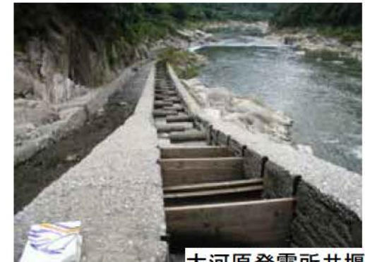
大河原発電所井堰
