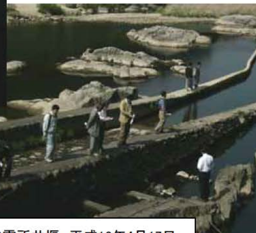
相楽発電所井堰 平成16年4月17日
