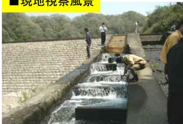
大河原発電所井堰 平成16年4月17日
