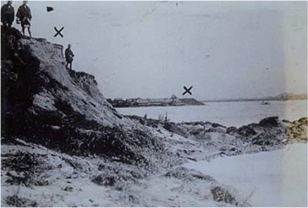
大正6年大冠村大塚(現高槻市)の堤防決壊破堤
