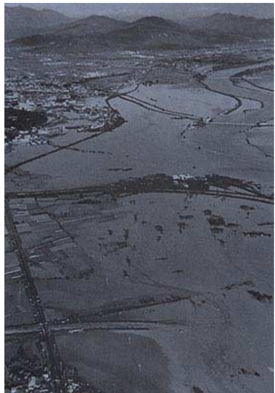
昭和47年桂川の出水によ る亀岡市の浸水
