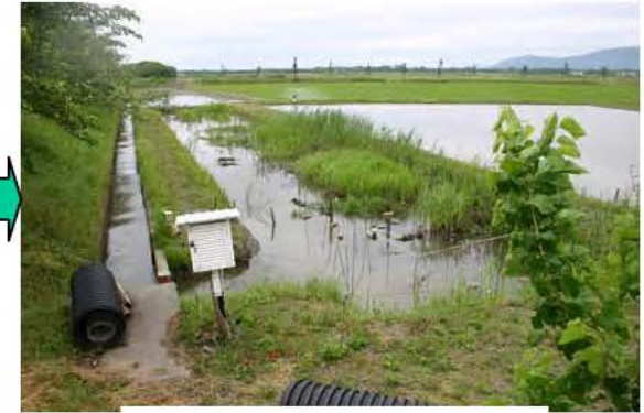
施工後1年3ヶ月 (H18.6.9)
