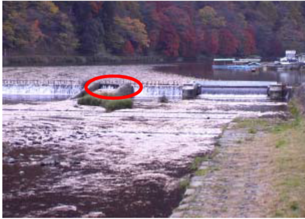
堰板により仕切られており落差が大きい)
