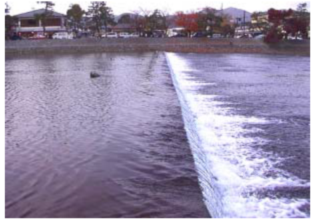
魚道が設置されていない)
