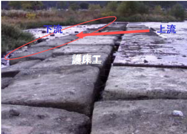
護床工によって流路が分断されている)
