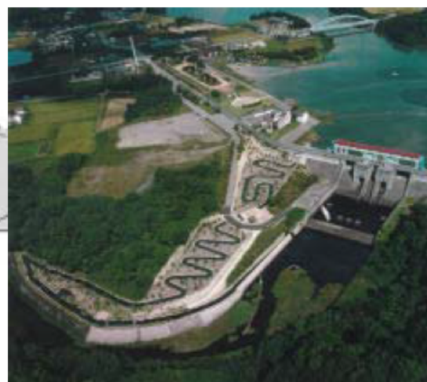
魚道の1例(青野ダム)
