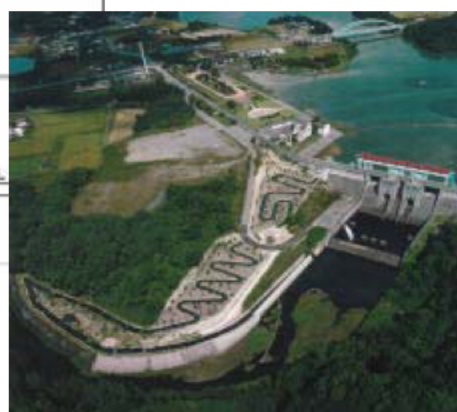
魚道の1例(青野ダム)
