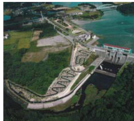
魚道の1例(青野ダム)
