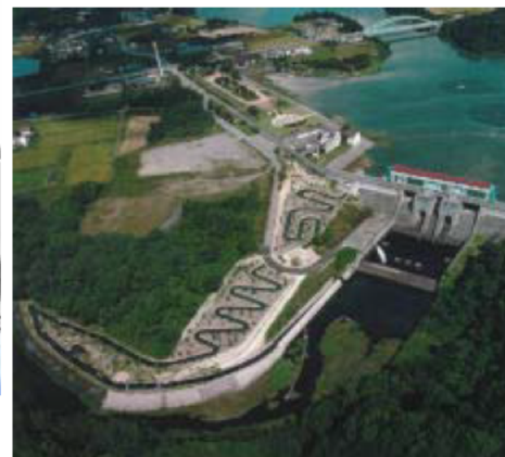
魚道の1例(青野ダム)
