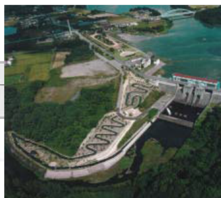
魚道の1例(青野ダム)
