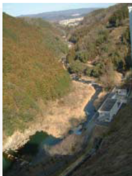
青蓮寺ダム下流の状況
