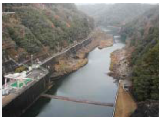
高山ダム下流の状況
