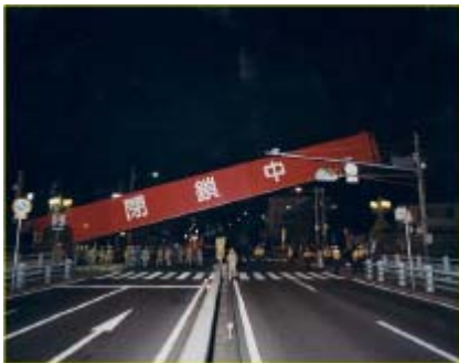
【防潮扉の「閉鎖訓練」】
