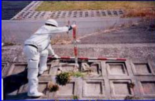
護岸の陥没
