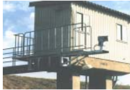
一体型高速巡回カメラ装置
