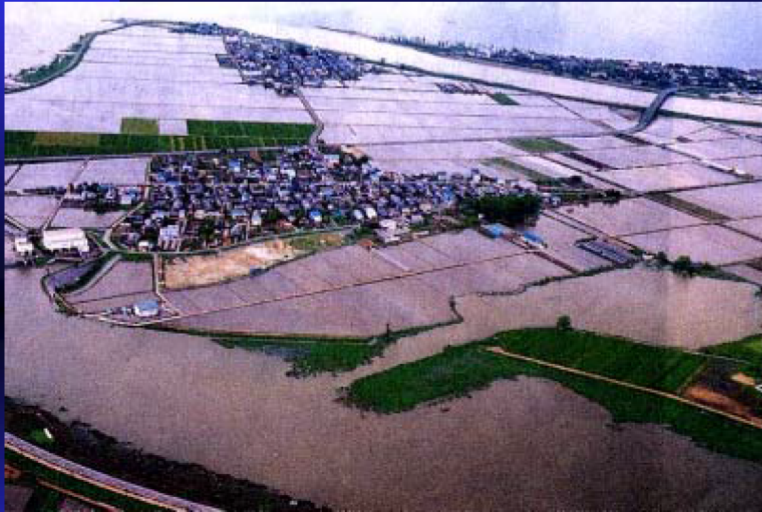
能登川町 大同川排水機場周辺
