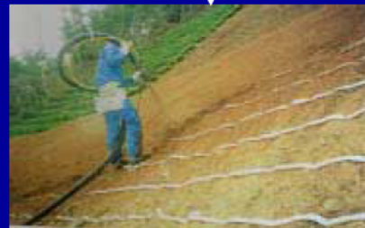
堆肥化、法面の緑化基材として利用
