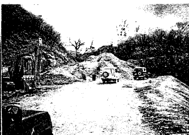
中腹より奥へ道路工事中
