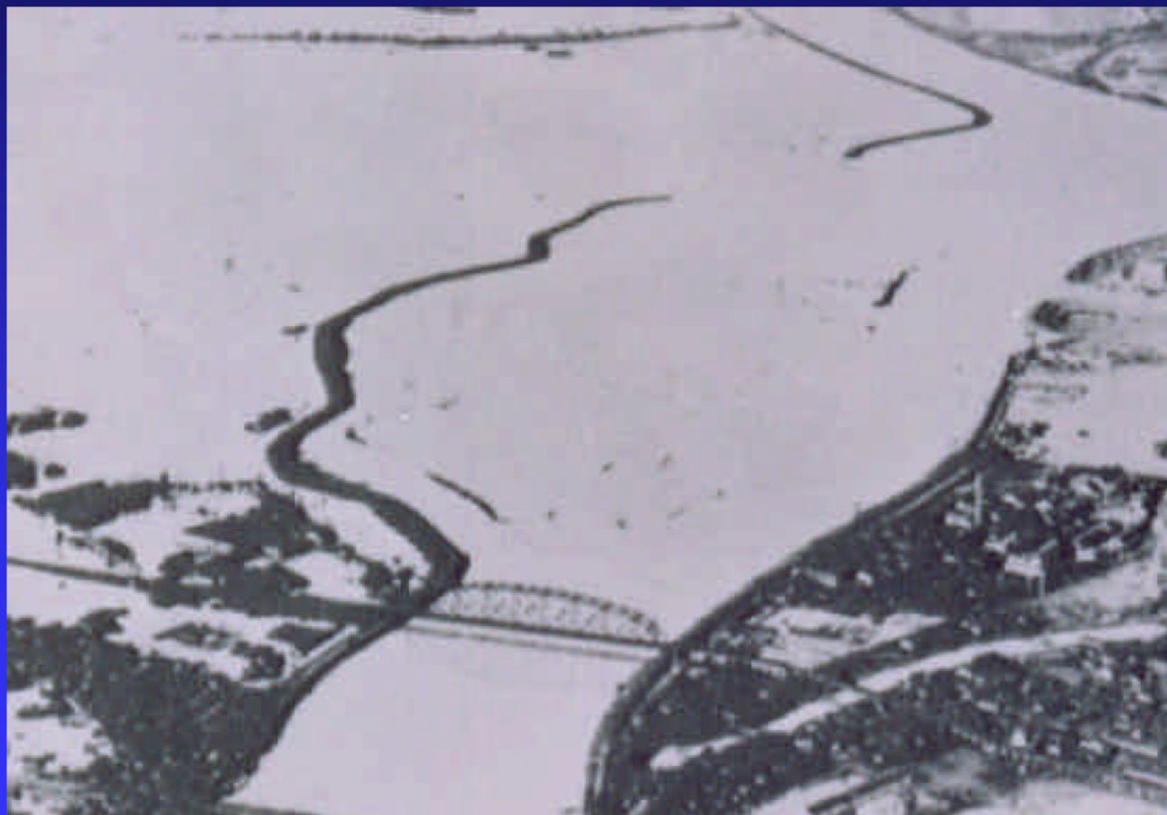
宇治川左岸( 京都府久世郡久御山町) の破堤による浸水
