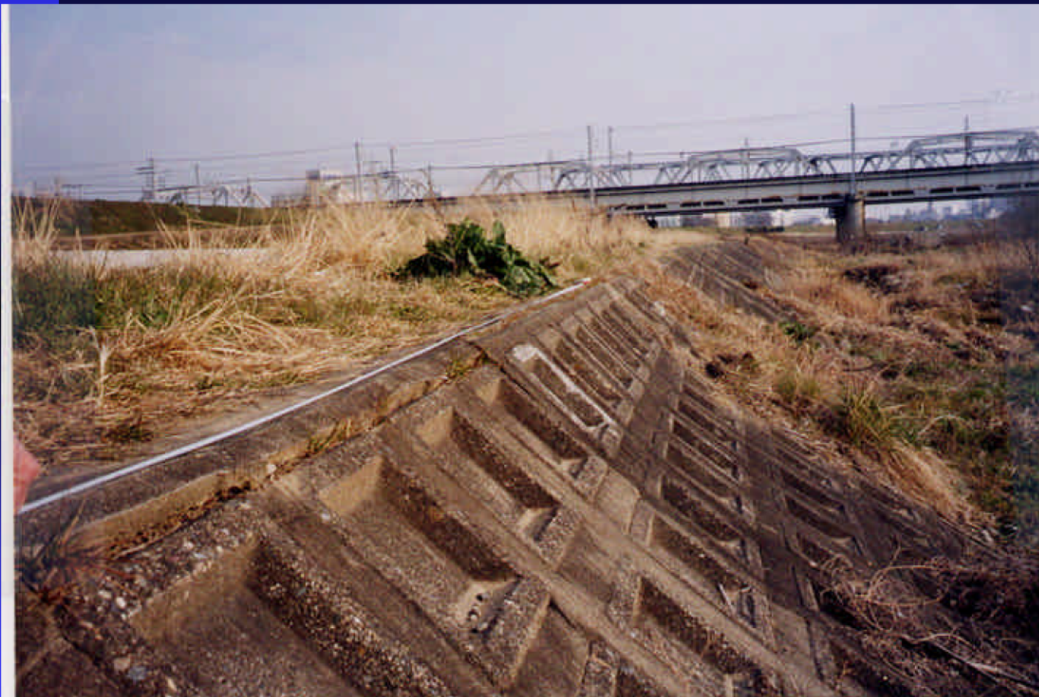
補修前の状況
