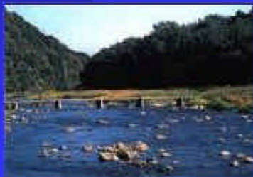
朝日町潜水橋
