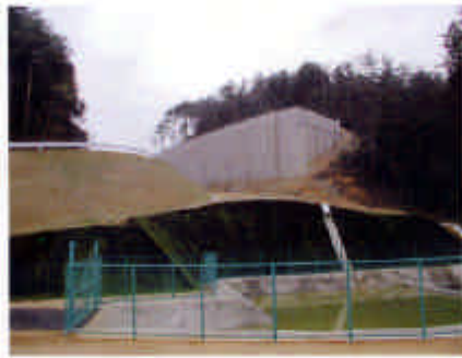
付替県道大津信楽線 3工区道路改良工事
