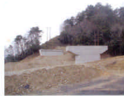
付替県道大津信楽線 4 5号橋下部工工事
