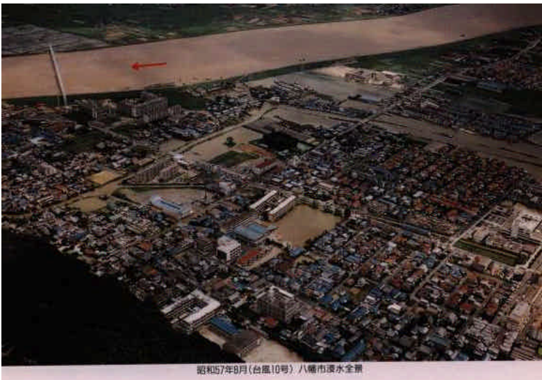
昭和57年8月(台風10号) 八幡市浸水全景
