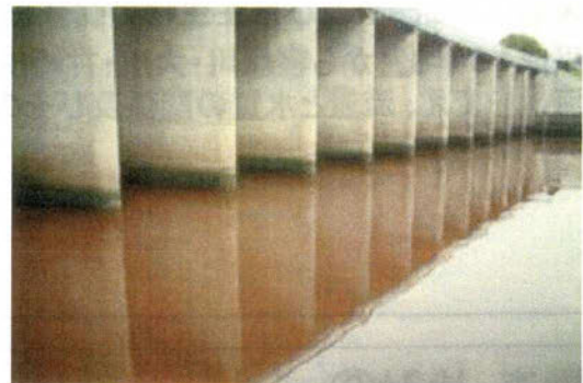
毛馬排水機場付近状況
