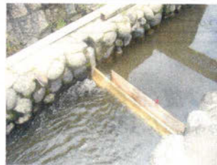
写真2 流量の調節(越流水深を設定)
