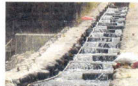
第1回目(5月30日)切り欠き越流水深:23cm(魚道中央部)
