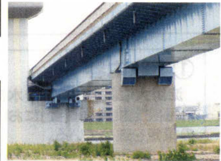
工事完了した落橋防止
