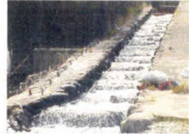
第2回目(5月31日)切り欠き越流水深:28cm(魚道中央部)
