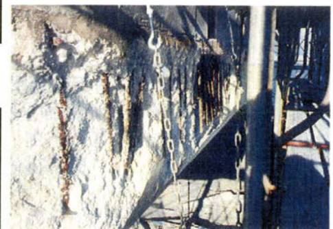
3号堰柱操作台の鉄筋腐食状況
