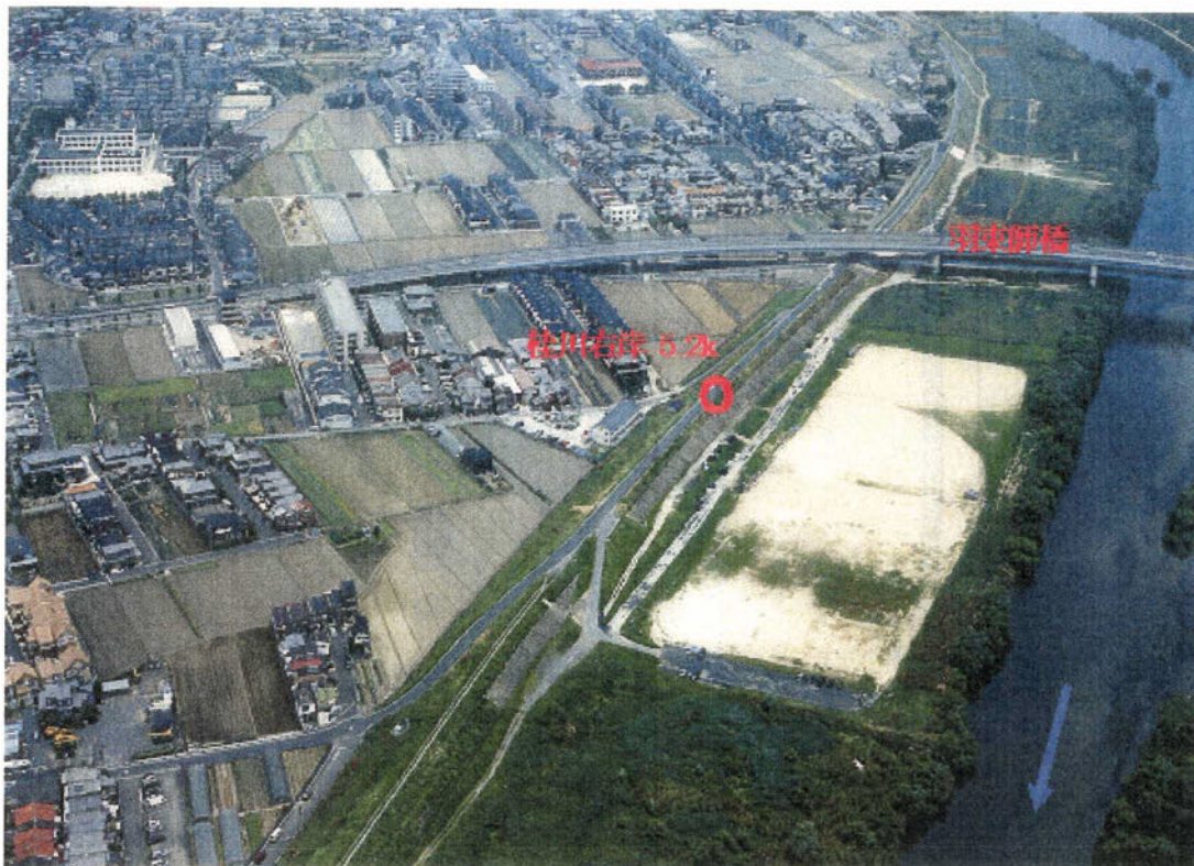
桂川右岸 5.2k 付近の状況
