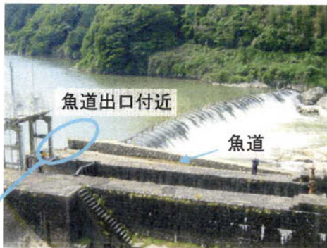
写真1 魚道の全景(相楽発電所取水堰)
