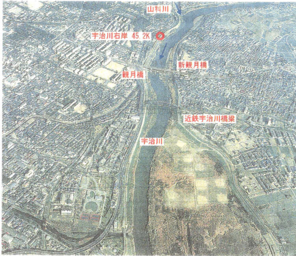
宇治川右岸 45.2k 付近の状況
