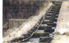
第3回目(6月1日)切り欠き越流水深:13cm(魚道中央部)
