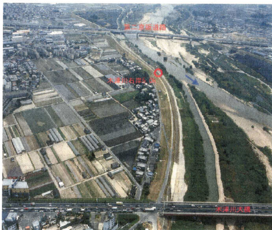
木津川右岸 5.0k 付近の状況
