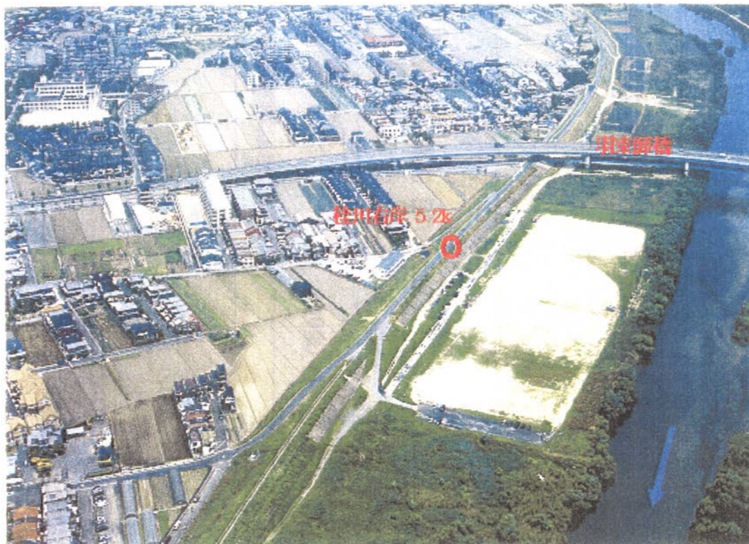
桂川右岸 5.2k 付近の状況
