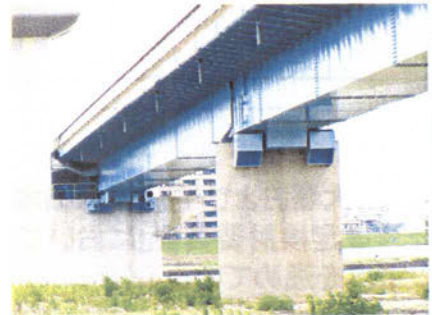
工事完了した落橋防止
