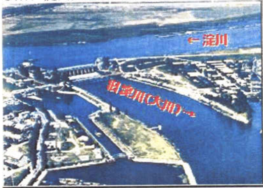
S47.4 淀川大堰着工前の状況
