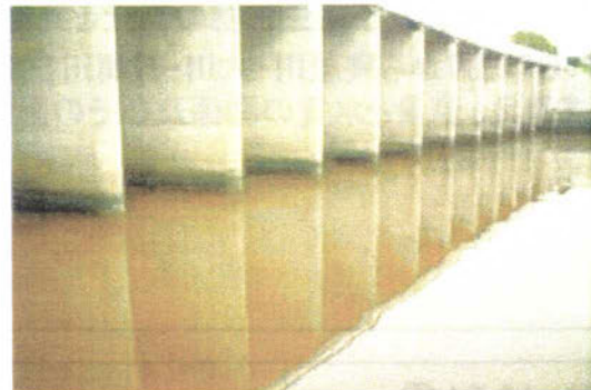
毛馬排水機場付近状況
