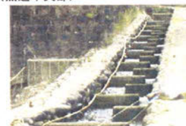
第3回目(6月1日)切り欠き越流水深: 13cm (魚道中央部)
