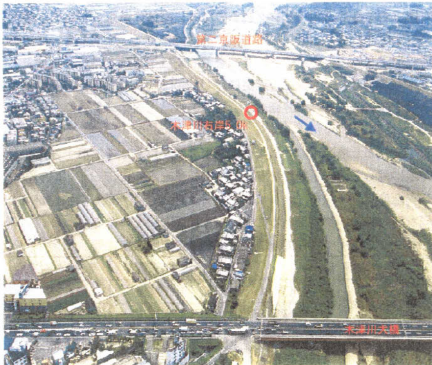
木津川右岸 5.0k 付近の状況
