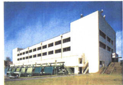
工事完了した外壁
