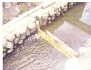
写真2 流量の調節(越流水深を設定)
