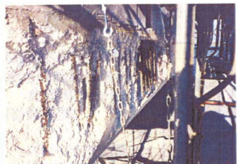
3号堰柱操作台の鉄筋腐食状況
