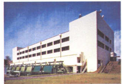
工事完了した外壁
