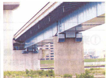
工事完了した落橋防止
