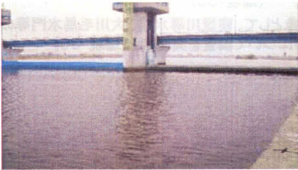
淀川堰下流状況
