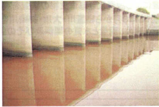
毛馬排水機場付近状況
