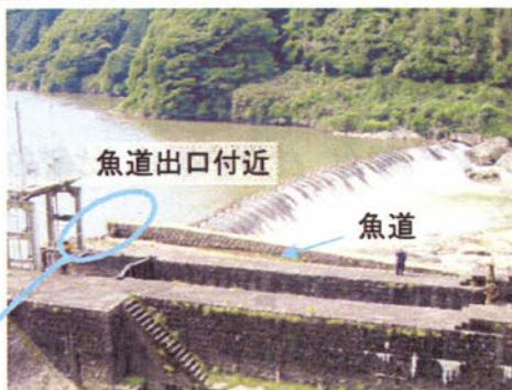
写真1 魚道の全景(相楽発電所取水堰)
