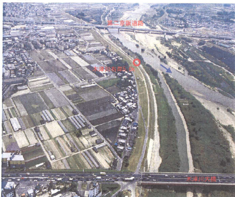
木津川右岸 5.0k 付近の状況
