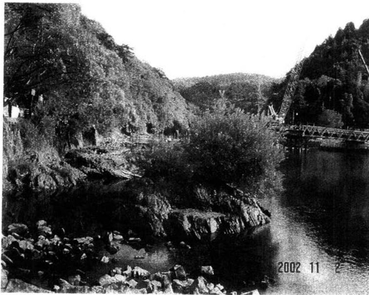
護岸工事前の亀石周辺
