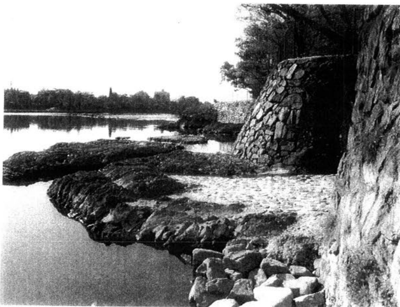
護岸工事後の亀石周辺 コンクリートで固められた
