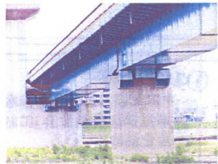
工事完了した落橋防止
