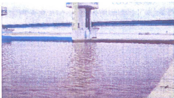
淀川堰下流状況
