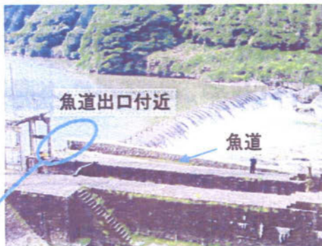
写真1 魚道の全景(相楽発電所取水堰)
