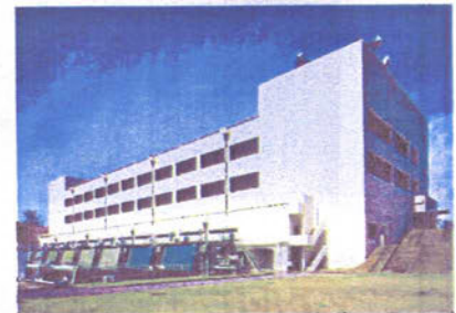
工事完了した外壁
