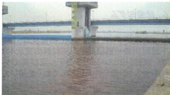
淀川堰下流状況
