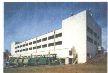
工事完了した外壁
