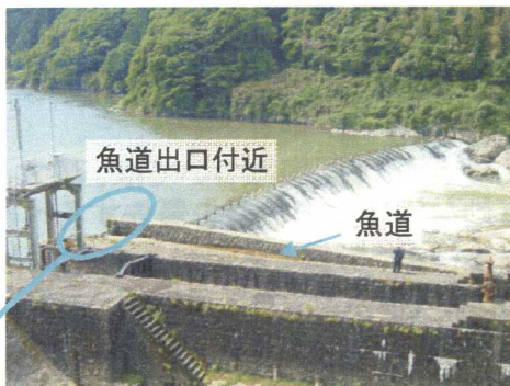
写真1 魚道の全景(相楽発電所取水堰)
