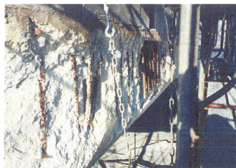
3号堰柱操作台の鉄筋腐食状況
