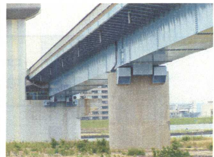
工事完了した落橋防止
