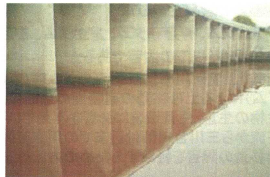
毛馬排水機場付近状況
