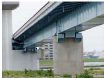
工事完了した落橋防止
