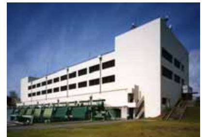
工事完了した外壁
