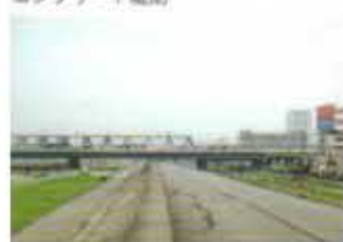
コンクリート堤防
