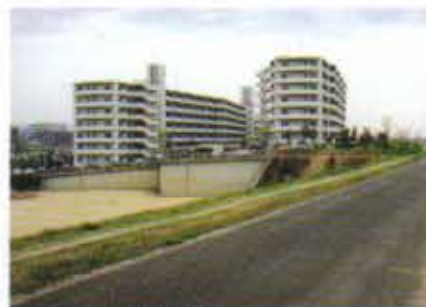
スーパー堤防(高規格堤防)
