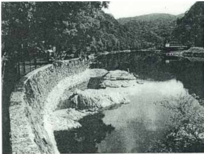
現況写真 河道掘削関連、宇治山田護岸工事によって様変わりした亀石
