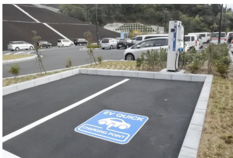
道の駅「みさき」(大阪府岬町)
