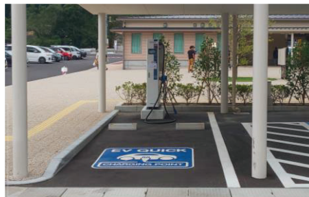
道の駅「海南サカス」(和歌山県海南市) 【設置年月：令和5年9月】
