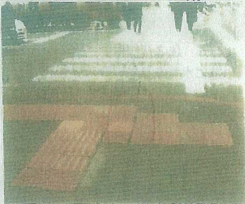
R25 中央区船場中央3交差点 (点字ブロック間に隙間がある)
