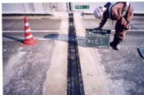
写真2 ゴム伸縮継ぎ手補修完了後
