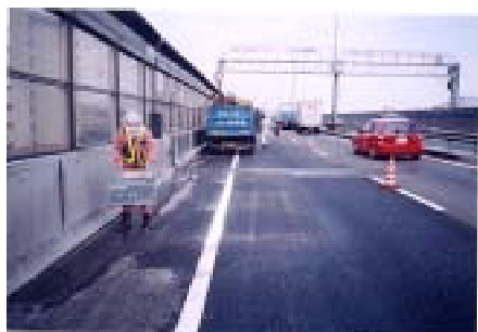
写真1 舗装補修完了後
