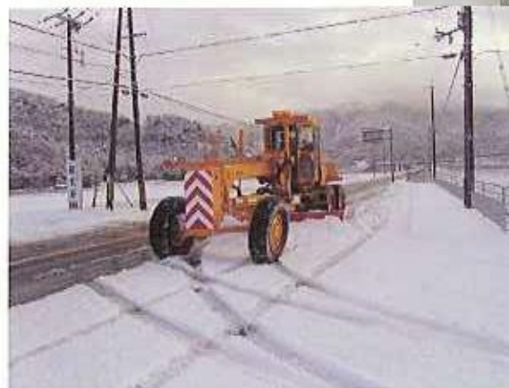
車道除雪状況 (滋賀)
