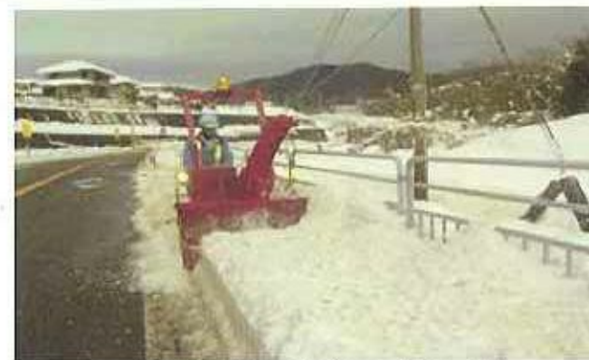
歩道除雪状況(福井)
