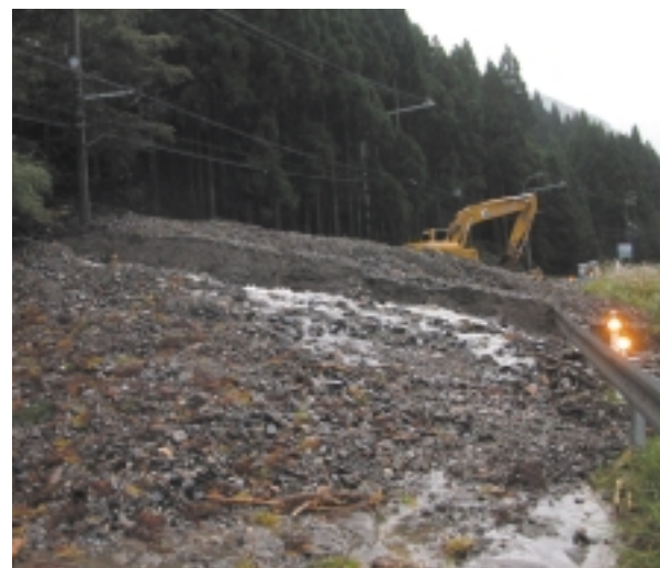
国道367号（大津市葛川梅ノ木町）
