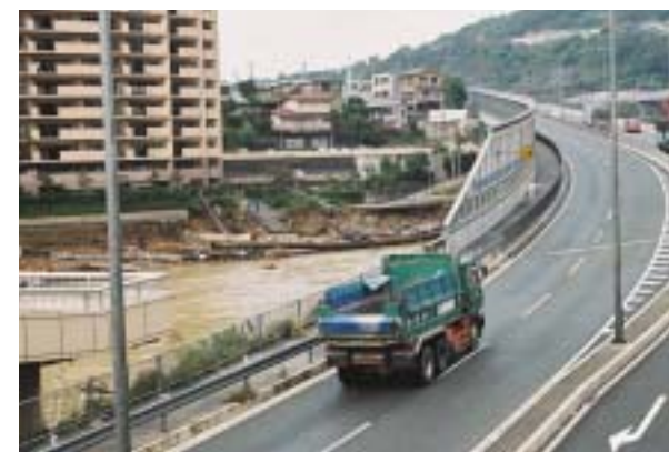
名塩道路(手前)と崩落した旧国道176号
