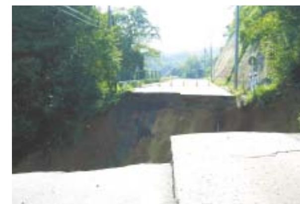
国道173号(綾部市寺町)
