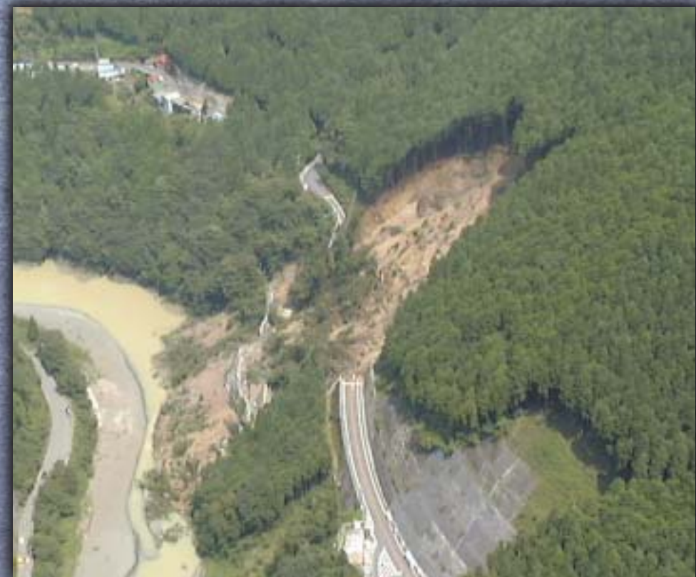
国道168号をおそった大規模な地すべり(H16.8.10 奈良県吉野郡大塔村)
