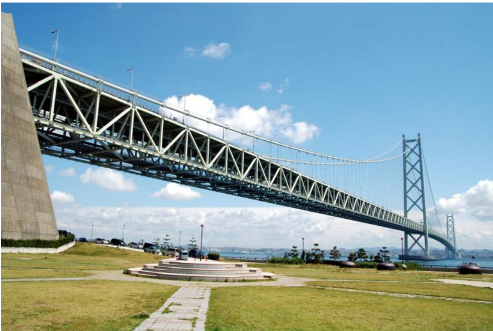
「淡路島から見た明石海峡大橋」(兵庫県)
