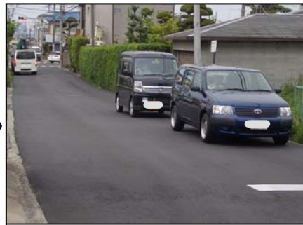
<開通後の状況>
