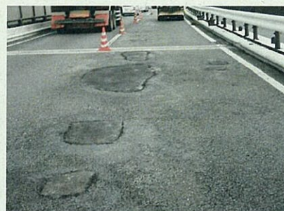
ポットホール補修後
