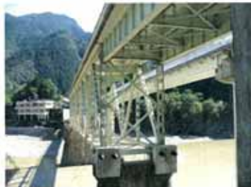
（P2～P3 鋼トラス橋の状況）
