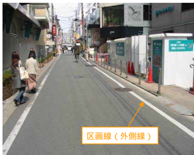
実験前の道路空間
