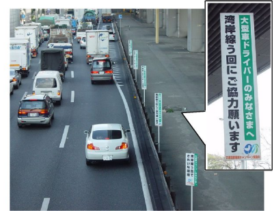
国道43号(五合橋上り)
