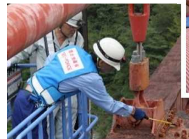
ケーブルの力 バー部の腐食
