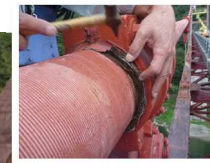
ケーブルの力 バー部の腐食
