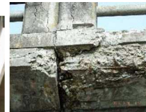
鉄筋の腐食
